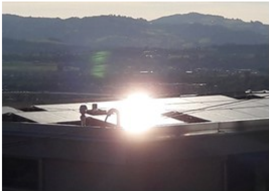
Figura 8: Esempio dell'effetto abbagliante di un impianto fotovoltaico su un tetto piano. In questo caso i moduli sono orientati con una leggera inclinazione verso est e ovest.
